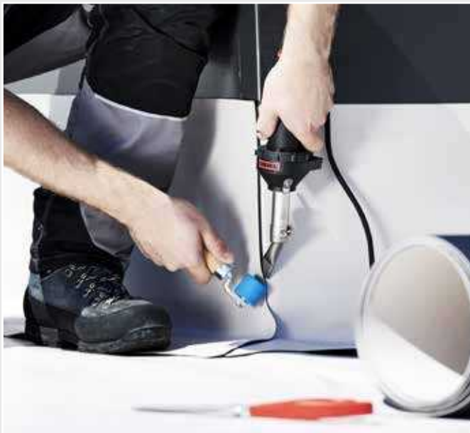
HOT JET S idéal pour les travaux de détail sur le toit.
