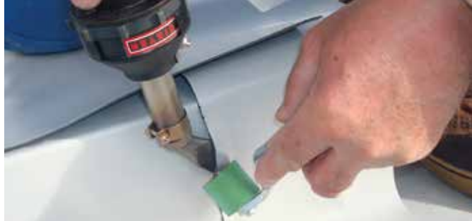
HOT JET S avec buse d'angle lors du soudage sur un bord en T d'un toit.
